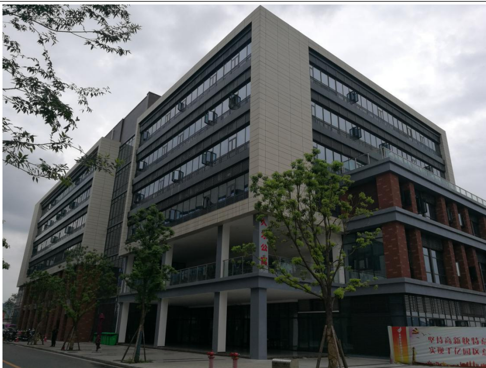
图 5-6 项目 A 区公建部分绿化措施现状
